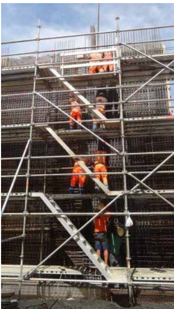
links: Menschen-Pyramide auf der Baustelle Model Weinfelden
